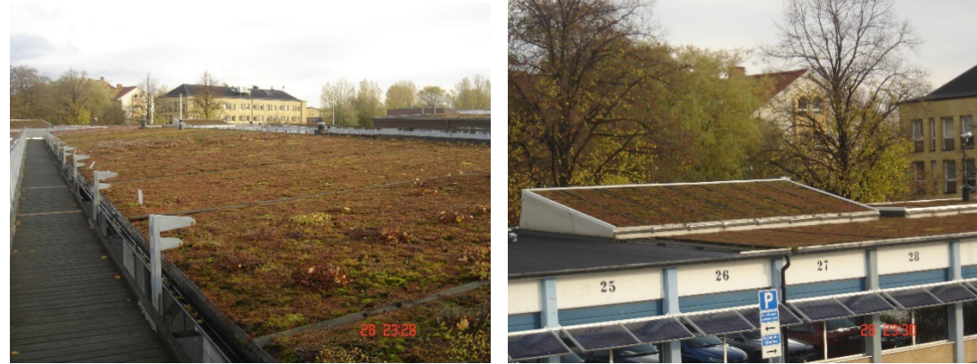
Foto 1: Malmö’de küresel ısınmanın etkisiyle oluşan sel baskınlarını önlemek için yeşil çatılar inşa edilmiştir (Yılmaz, 2008).
